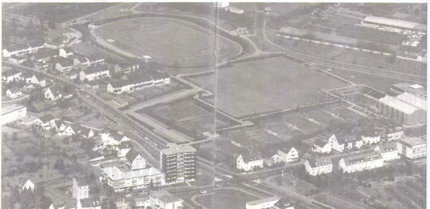
LUFTBILDAUFNAHME DER ANLAGE WASSERLAND
