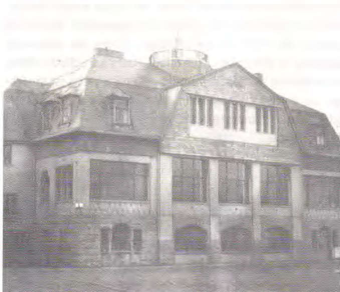
TENNISUMKLEIDEKABINEN ANLAGE REUTERSTRASSE
